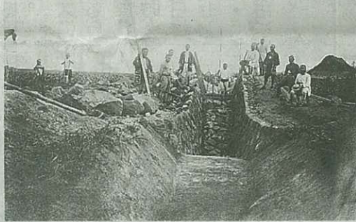
かんがい溝工事の様子。「斜段」と呼ばれる落差部分を設けてかんがい溝の高低差を調整した(いずれもニセコ・有島記念館提供)
